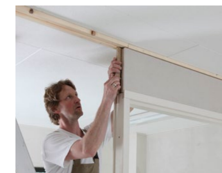
↑ Ook de verbindingen tussen kozijnpaneel, kozijn en wand-paneel worden verlijmd met FAAYFIX®, voor één massief geheel.
