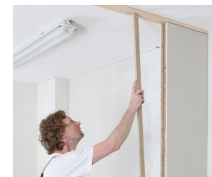
↑ Door de spaanplaat verbindingveer in de van FAAYFIX® voorziene groef te kloppen, ontstaat een zeer solide verbinding tussen de afzonderlijke panelen.
